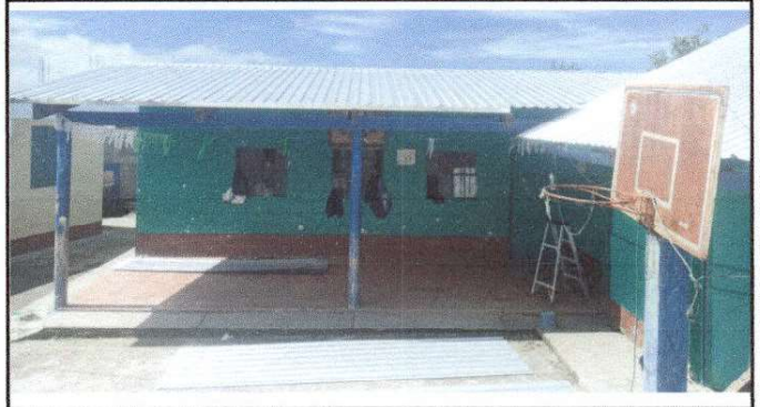
Foto 2: finalizacion de cubierta de lamina Troquelada, sustitucion de capote para lamina troquelada
