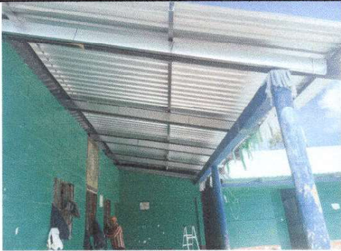
Foto 1: vista Finalizacion de sustitucion de lamina, por lamina Troquelada
