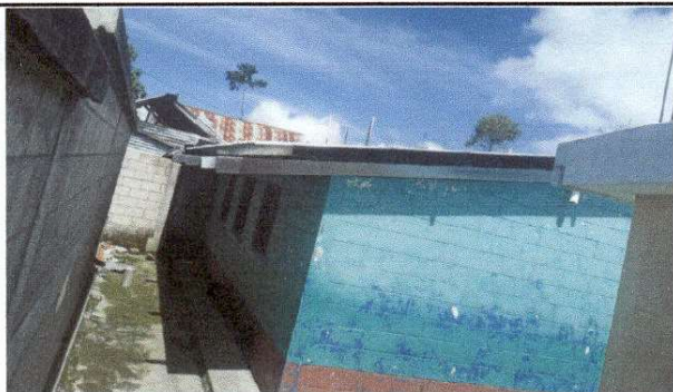
Foto 5: vista lateral, finalizacion de cubierta de lamina
