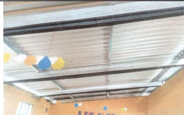
Foto 4: vista interior. Finalizacion de instalacion de estructura de metal
