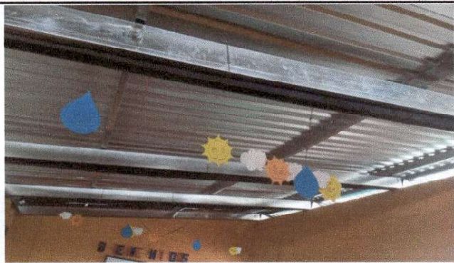
Foto 3: vista interior, Finalizacion de sustitucion de soporte de madera por metal
